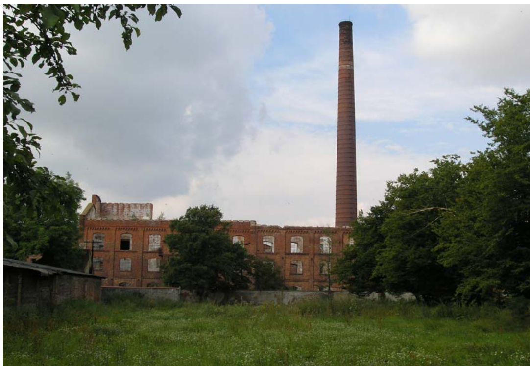
Zdjęcie 29. Cukrownia Izabelin w Głinojecku
