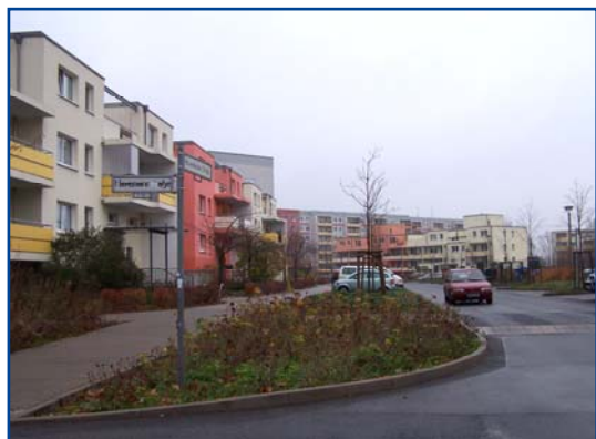
Ryc.10. Zabudowa tarasowa ulicy Havemannstrasse w miejscu wyburzeń
