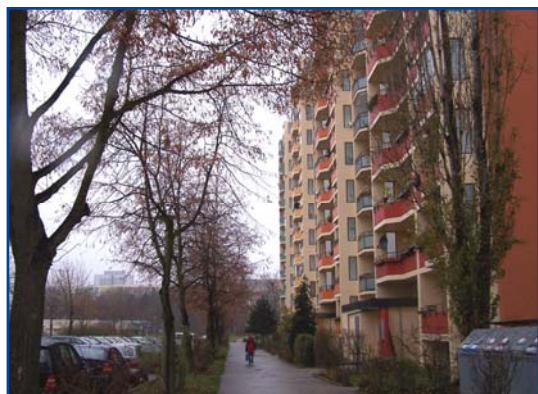
Ryc.6. Odnowiona elewacja bloku przy ulicy Lea-Grundig-Strasse
