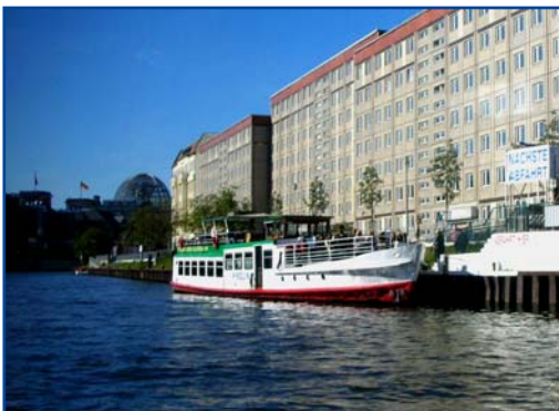
Ryc.23. Widok przystani oraz zabudowy nabrzeżnej
