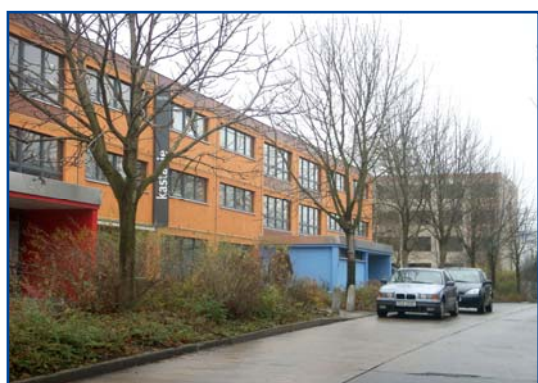
Ryc.5. Nowe budynki w miejscu wyburzeń przy ulicy Kastanienalle
