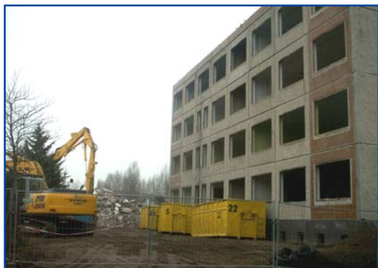
Ryc.4. Wyburzanie zabudowy przy ulicy Kastanienalle
